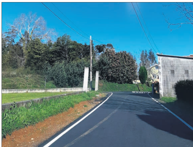
Os traballos melloraron as condicións de seguridade dos viais.
