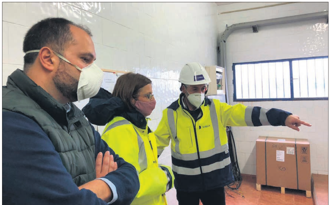
Visita á planta potabilizadora.
