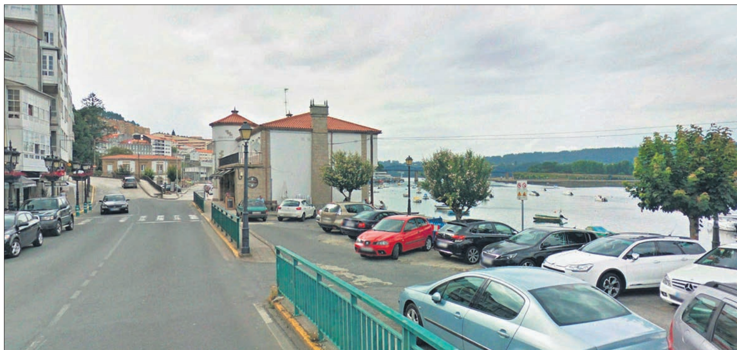
Os traballos na avenida Saavedra Meneses servirán para mellorar a zona de aparcadoiro.
