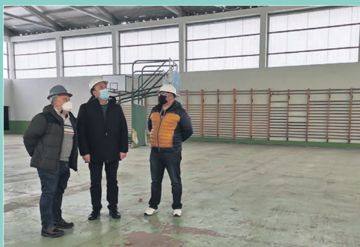
O alcalde pontés supervisou os traballos no recinto
