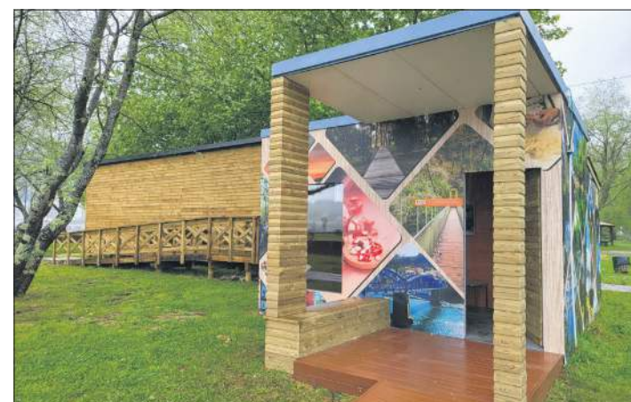
O Concello executou labores de mellora no exterior da OIT.
