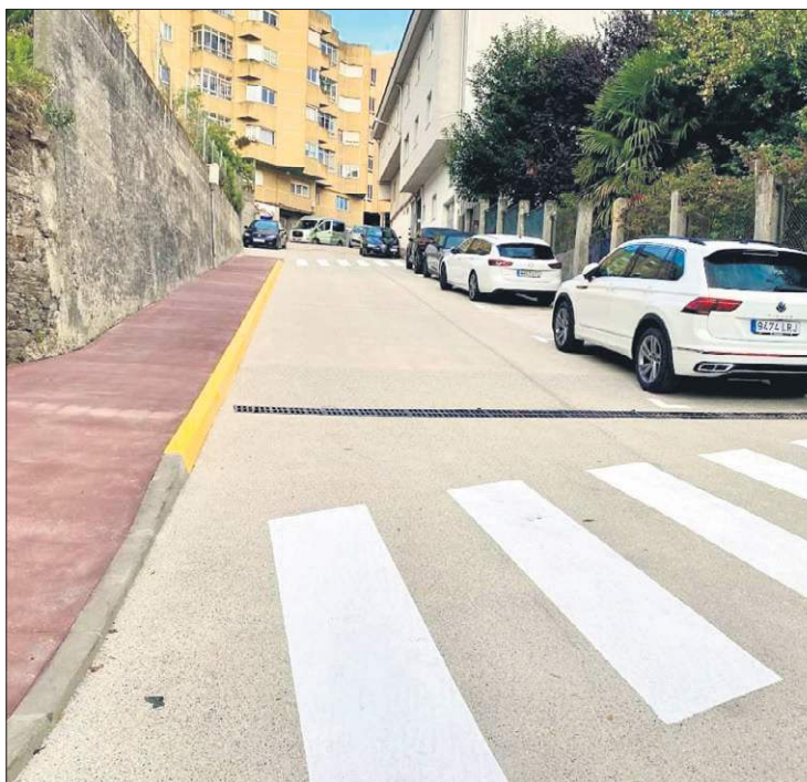
Novo aspecto da rúa Torrente Ballester tralas obras.
