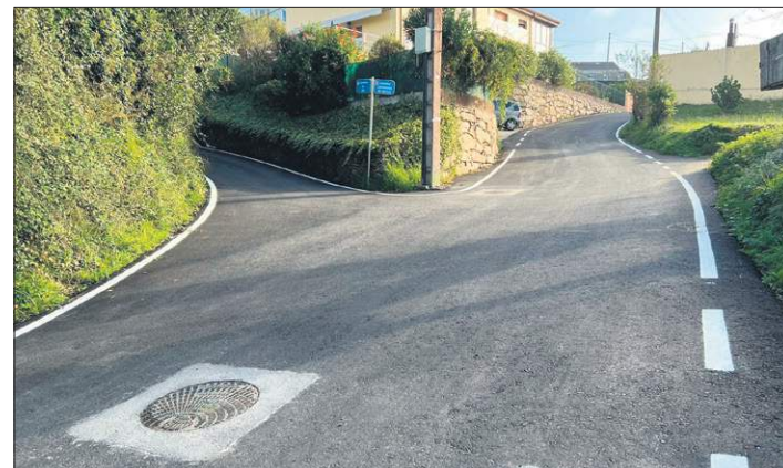
Remate das obras nun dos viais.
