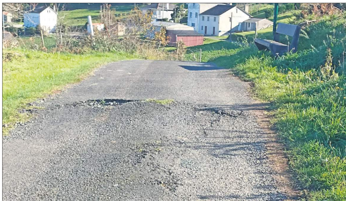
Un dos viais que se reparará en Ortigueira.
