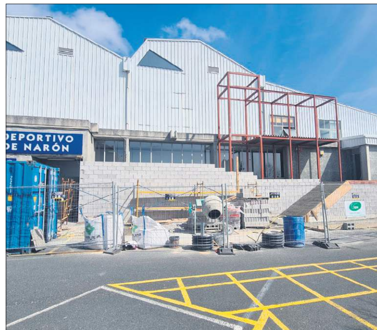
Obras no pavillón de A Gándara.
