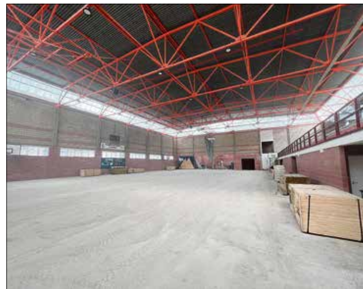
Obras no pavimento do Polideportivo Municipal de Cedeira.
